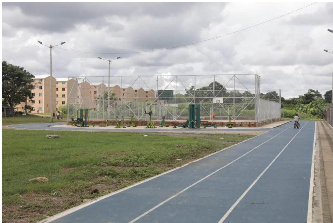
(Pista multipropósito del municipio de Arboletes, foto de Rodrigo Mora Quiroz)
