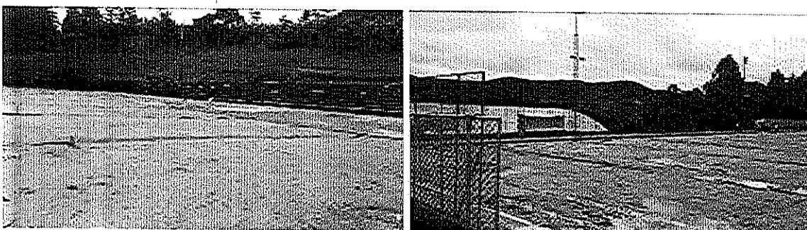
Foto 5 y 6. Problemas de compactación en la construcción de la cancha de fútbol sintética en El Santuario.
