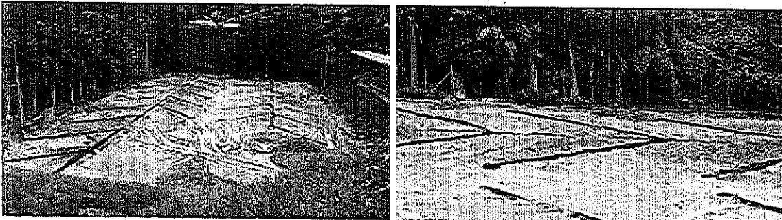
Foto 3 y 4. Problemática de saturación del suelo en la construcción de la cancha de fútbol sintética en Betania.
