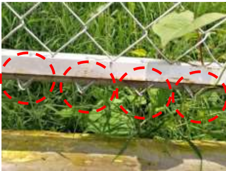
Foto: Captura cancha de fútbol. Titiribí - Antioquia Cerramiento malla eslabonada elementos puntiagudos amarres deficientes Elaborado: Juan Pablo Madrid García – Contralor Auxiliar.
