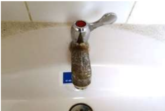
Foto: Captura Patinódromo, Necoclí - Antioquia Oxidación en cromos de grifería y elementos Elaborado: Juan Pablo Madrid García – Contralor Auxiliar.
