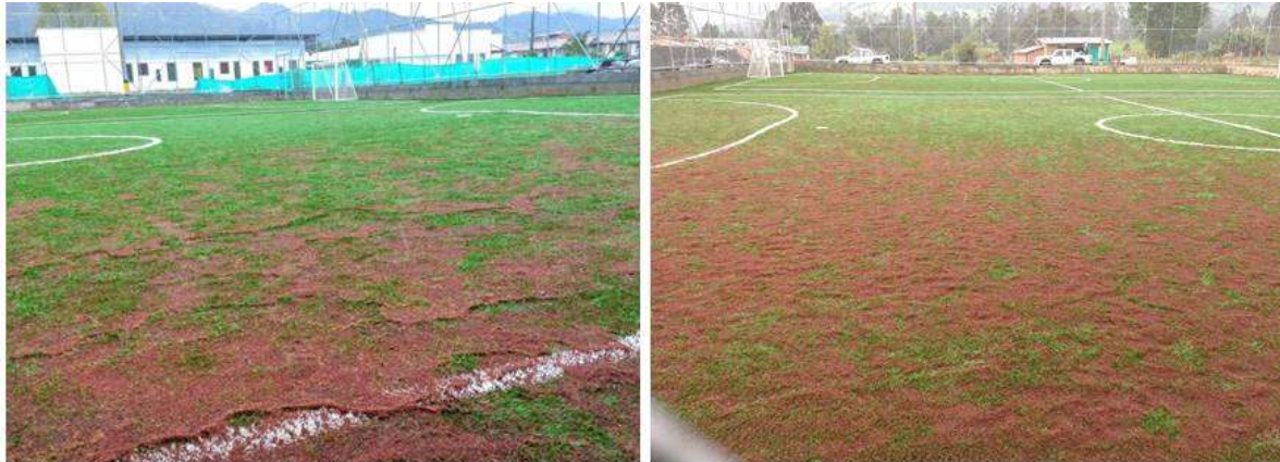
Exceso de material y nivel freático alto pese a filtros.
