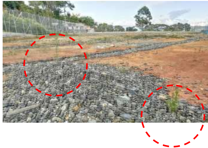
Foto: Captura cancha de fútbol, Betulia - Antioquia Contaminación de sistema de filtros y drenajes Elaborado: Juan Pablo Madrid García – Contralor Auxiliar
