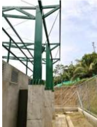
Foto: Captura Patinódromo. Necoclí - Antioquia Pendiente instalación de tapa de cárcamos – cubierta metálica y protección en barrera exterior Elaborado: Juan Pablo Madrid García – Contralor Auxiliar.
