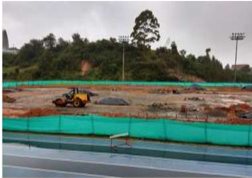
Estado actual de la cancha en obras de excavaciones y conformación de filtros de aguas lluvias. Fuente: Visita al sitio equipo auditor. Elaboró: Jaime Andrés Grisales Gallego/Profesional Universitario
