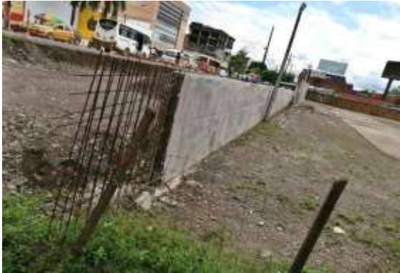
Foto: Captura tramo urbano ciclo infraestructura. Apartado - Antioquia Construcción muros de contención – conformación de llenos para construcción de andén Elaborado: Juan Pablo Madrid García – Contralor Auxiliar.
