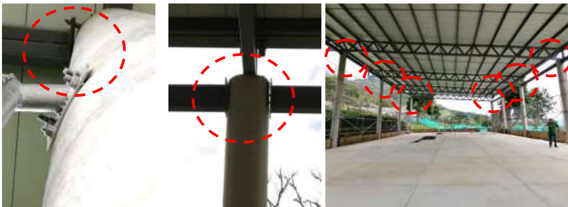
Foto: Captura cancha de futbol. Valparaíso - Antioquia Platinas y anclajes, estructura metálica de cubierta Elaborado: Juan Pablo Madrid García – Contralor Auxiliar
