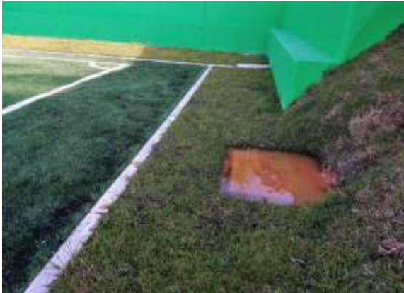
Se conserva caja de empalme filtro colapsado sector inundado, nivel freático alto. Fuente: Visita al sitio equipo auditor Elaboró: Jaime Andrés Grislaes Gallego/profesional Universitario
