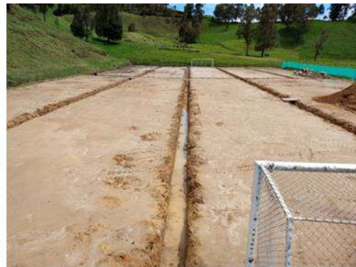
Estado actual de la cancha en obras de excavaciones y conformación de filtros de aguas lluvias. Fuente: visita al sitio equipo auditor Elaboró: Jaime Andrés Grisales Gallego/Profesional Universitario
