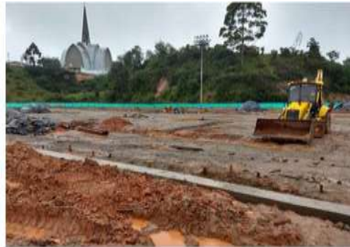
Estado actual de la cancha en obras de excavaciones y conformación de filtros de aguas lluvias. Fuente: Visita al sitio equipo auditor. Elaboró: Jaime Andrés Grisales Gallego/Profesional Universitario
