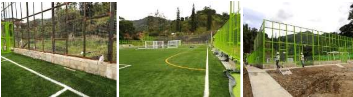
Foto: Captura cancha de fútbol. Copacabana - Antioquia Construcción de cerramiento perimetral – conformación de andenes y senderos Elaborado: Juan Pablo Madrid García – Contralor Auxiliar.
