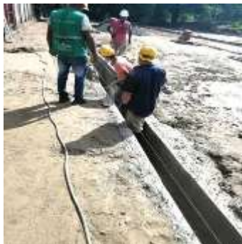
Foto: Captura cancha de fútbol. Sopetrán - Antioquia Excavaciones para filtros - obras de drenaje - Nivelación y explanación de la superficie Elaborado: Juan Pablo Madrid García – Contralor Auxiliar.
