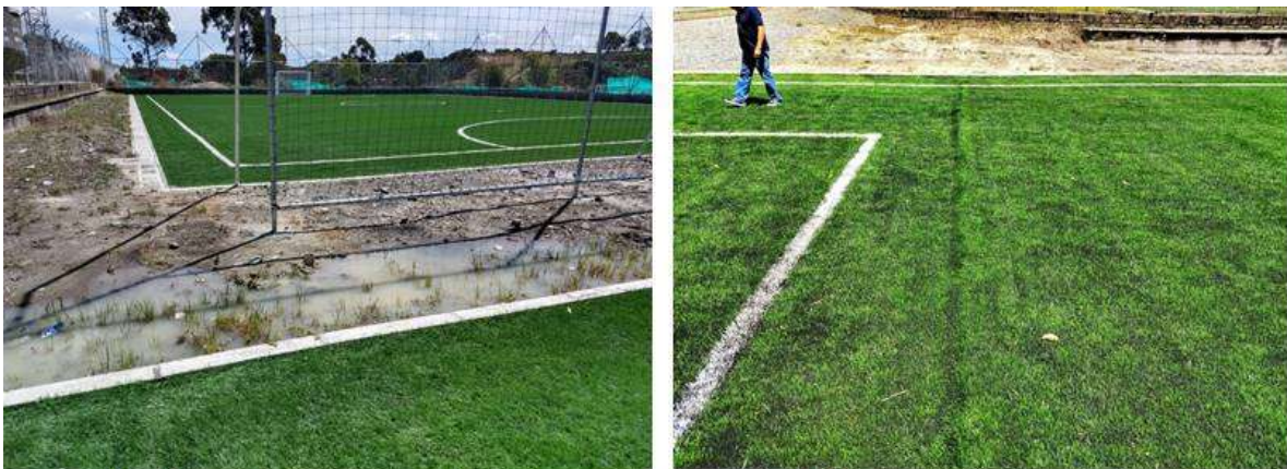
Se observa deficiencias en la calidad de los empates de los rollos de la grama sintética. Fuente: visita al sitio equipo auditor Elaboró: Jaime Andrés Grislaes Gallego/Profesional Universitario
