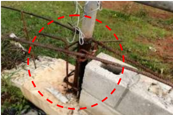
Foto: Captura cancha de fútbol. Betulia - Antioquia Aceros expuestos a condiciones climáticas sin protección Elaborado: Juan Pablo Madrid García – Contralor Auxiliar.
