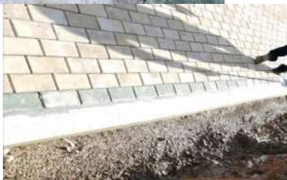
Foto: Captura cancha de fútbol. Angelópolis - Antioquia Asentamiento de adoquín – ajustes en concreto hacia vigas de confinamiento Elaborado: Juan Pablo Madrid García – Contralor Auxiliar-
