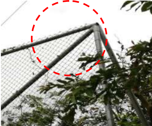
Foto: Captura Cancha de futbol. Tarso - Antioquia Cerramiento perimetral sin elementos de fijación y oxidación Elaborado: Juan Pablo Madrid García – Contralor Auxiliar.
