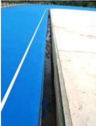
Foto: Captura Patinódromo. Necoclí - Antioquia Pendiente instalación de tapa de cárcamos – cubierta metálica y protección en barrera exterior Elaborado: Juan Pablo Madrid García – Contralor Auxiliar.
