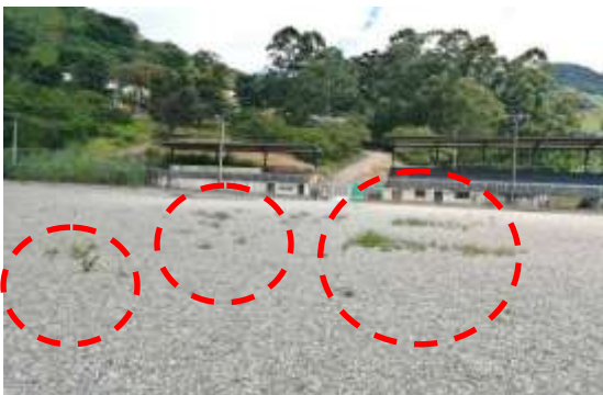
Foto: Captura cancha de fútbol. Betulia - Antioquia Contaminación de sistema filtrante Elaborado: Juan Pablo Madrid García – Contralor Auxiliar.
