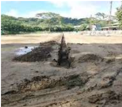
Foto: Captura cancha de fútbol. Sopetrán - Antioquia Excavaciones para filtros - obras de drenaje - Nivelación y explanación de la superficie Elaborado: Juan Pablo Madrid García – Contralor Auxiliar.
