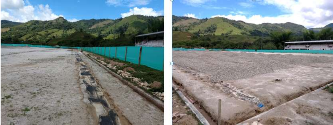
Estado actual de la cancha en estado de abandono sin cumplimiento de plazo aun. Fuente: Visita al sitio equipo auditor Elaboró: Jaime Andrés Grisales Gallego/Profesional Universitario
