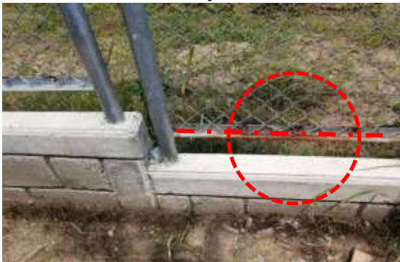
Foto: Captura Patinódromo. Necoclí - Antioquia Cerramiento perimetral sin elementos de fijación y oxidación – amarres con puntos de soldadura Elaborado: Juan Pablo Madrid García – Contralor Auxiliar.
