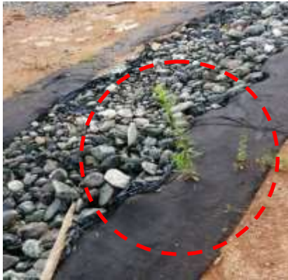
Foto: Captura cancha de fútbol, Betulia - Antioquia Contaminación de sistema de filtros y drenajes Elaborado: Juan Pablo Madrid García – Contralor Auxiliar
