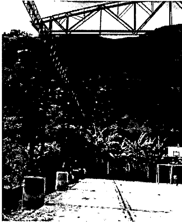
Foto 14. Instalación de estructura metálica incompleta para la placa polideportiva Vereda El Playón – Caicedo Levantó. Juan David González Orozco – Profesional Universitario.
