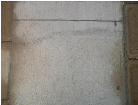
Fractura de andén en la entrada al escenario y fisuras presentadas en andenes perimetrales en el escenario de Entreríos
